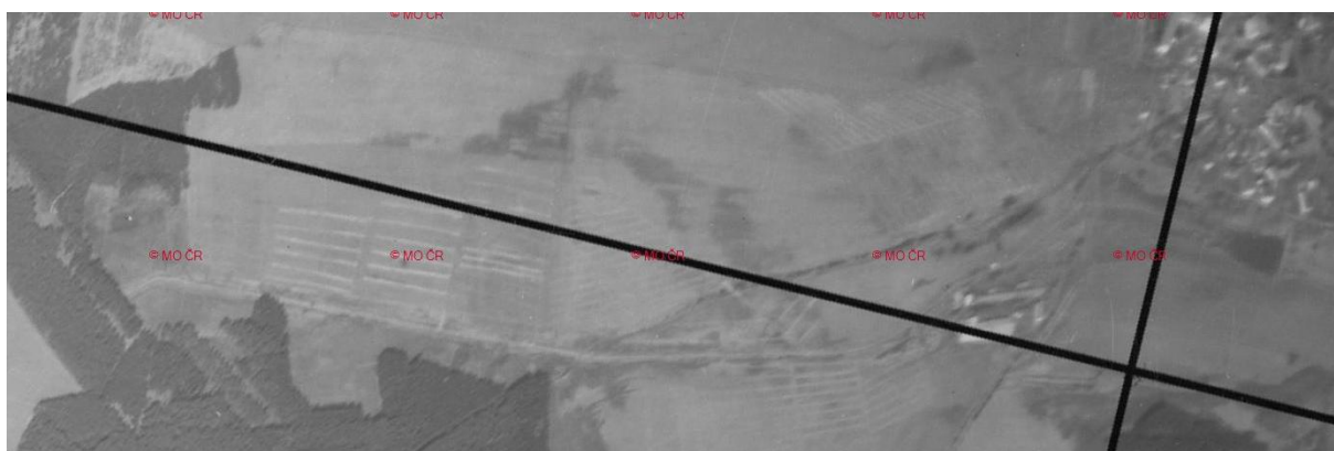
Obr. Letecký snímek z roku 1976 s viditelnými výkopovými rýhami po realizaci plošného odvodnění i trasa zatrubnění
