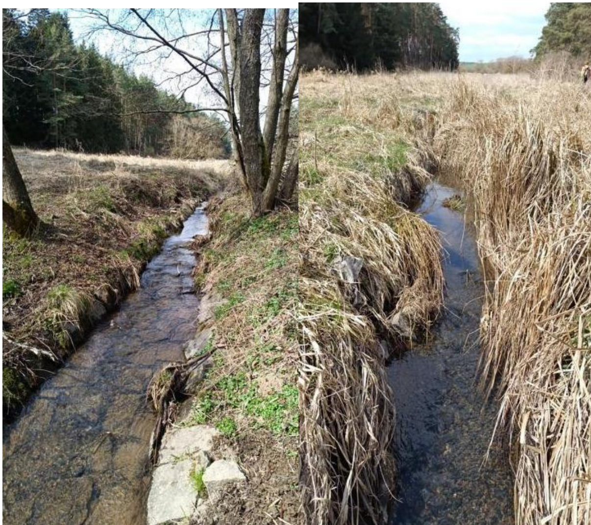
Obr. Stávající stav koryta (Zdroj AOPK ČR)
