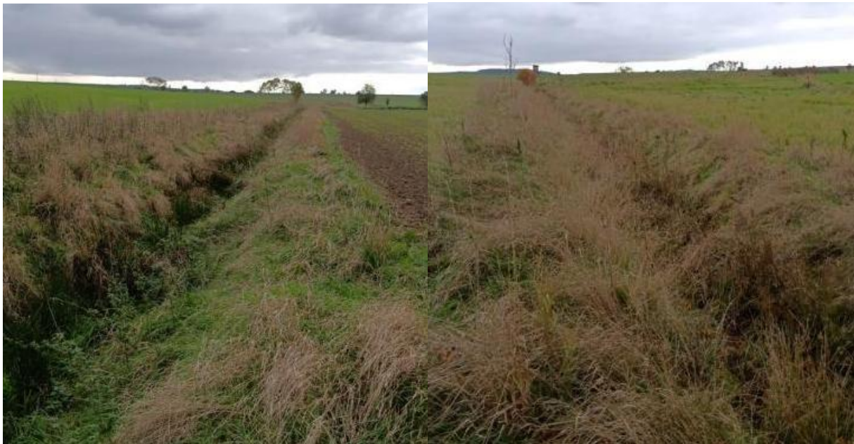
Obr. Stávající stav koryta (Zdroj AOPK ČR)
