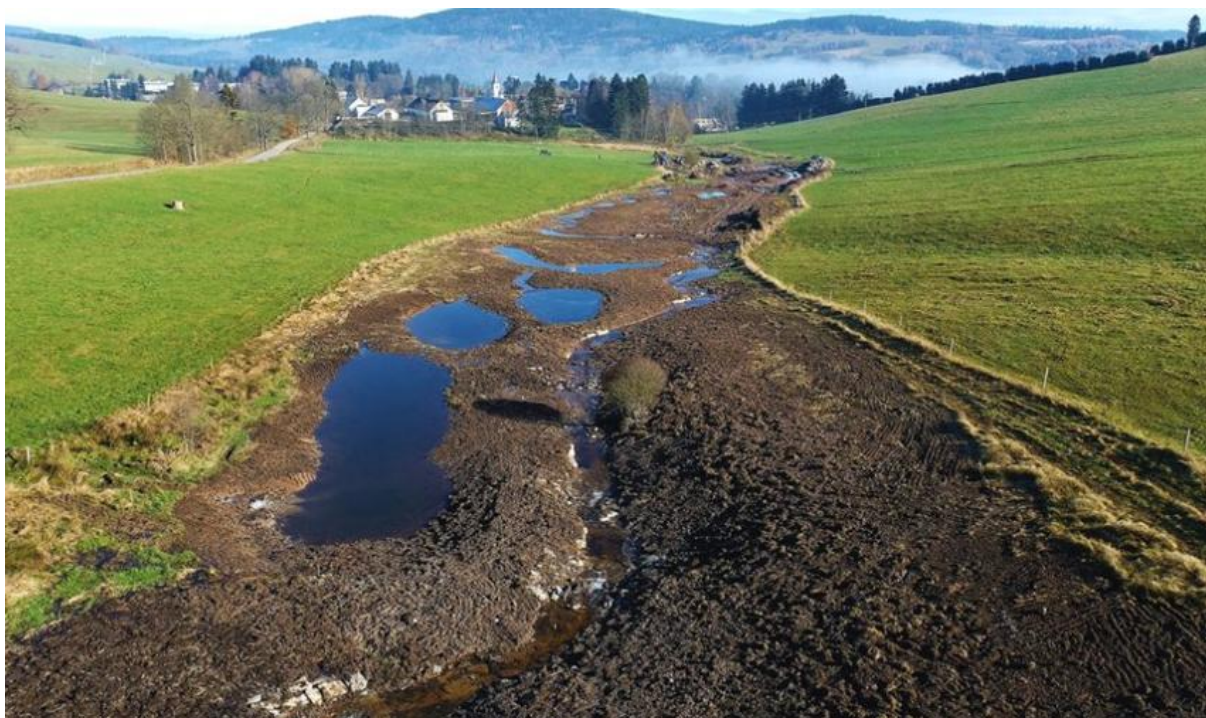
Obr. Cílový stav po otevření zatrubněného toku – Bartošovický p. (Foto Lesy ČR, www.adapteraawards.cz )
