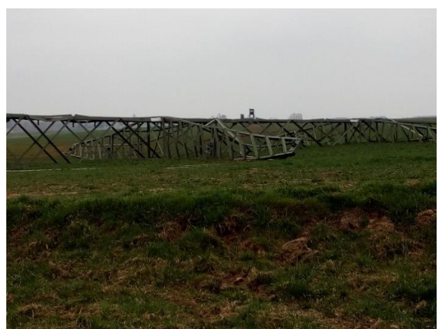
Demontovaný sloup vysokého napětí u Cebivi
