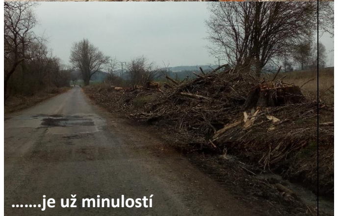
Stavební práce v dolní části obce
