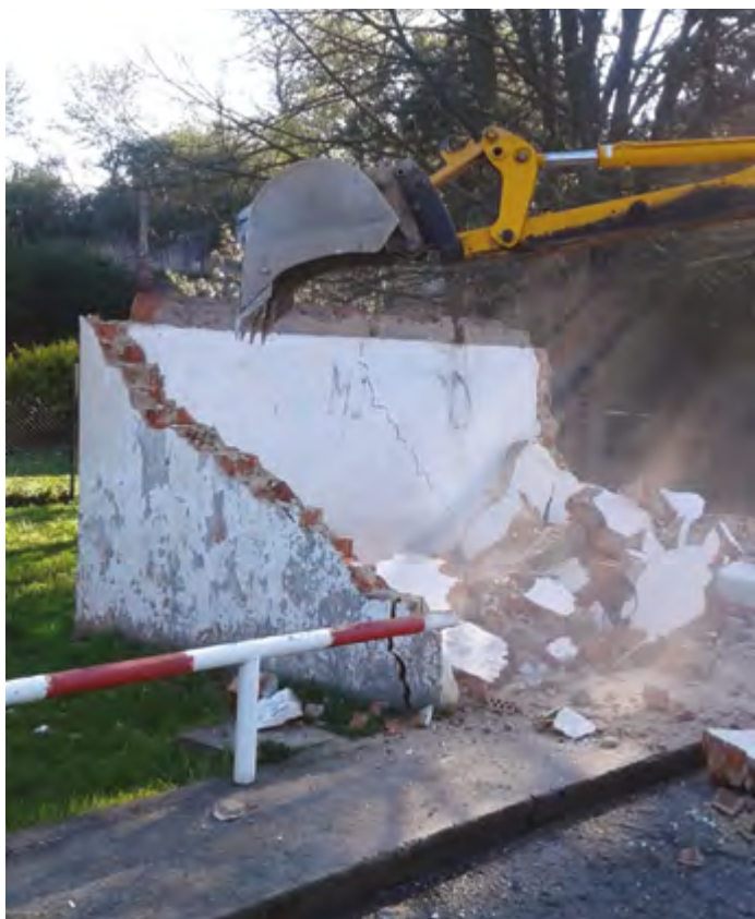
Demontáž staré autobusové zastávky
