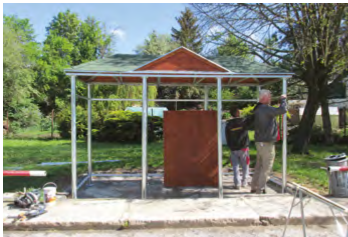
Montáž nové autobusové zastávky
