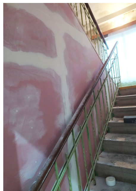
Schodiště na půdu
