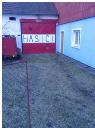
Vjezd a vrata starý stav
