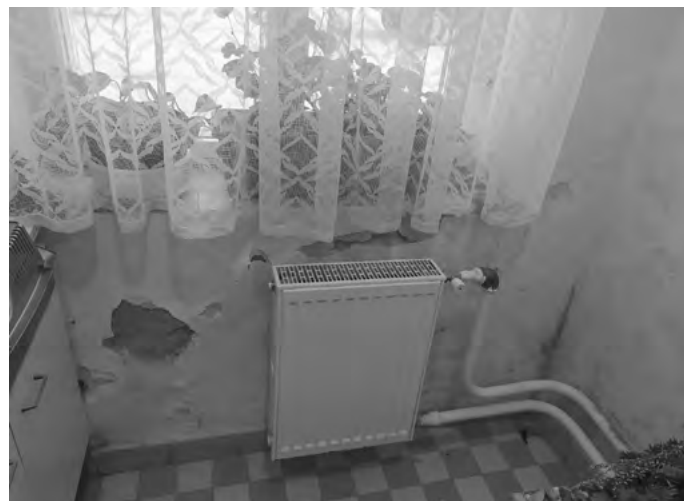
Kuchyňka na obecním úřadu - současný stav
