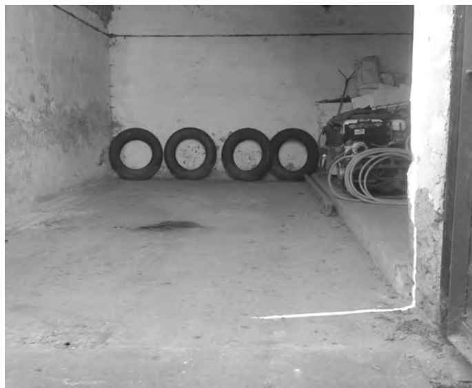
Garáž SDH před rekonstrukcí
