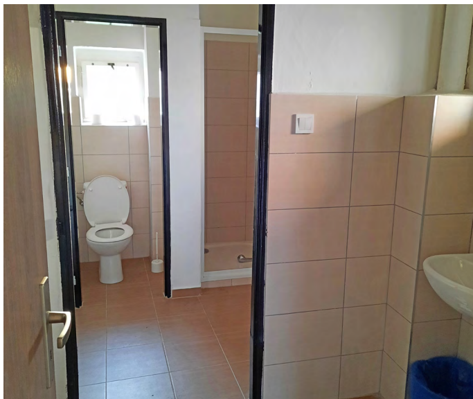
Nově opravené zázemí pro posilovnu
